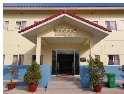
完成したクラチェ州病院外科・産科病棟
