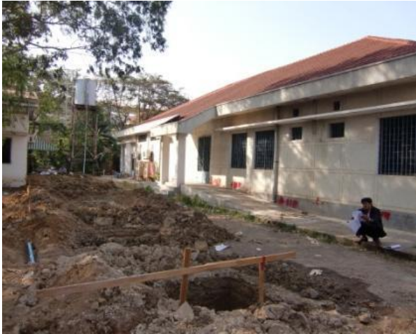
柱の基礎工事の様子（2012年12月）
