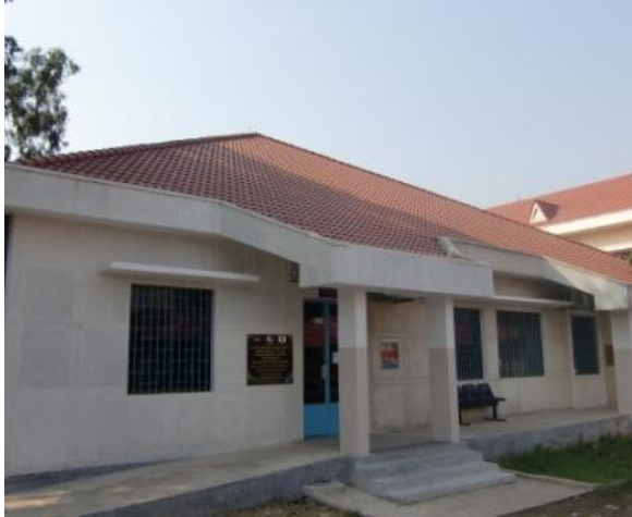
完成した手術棟の様子（2013年9月）
