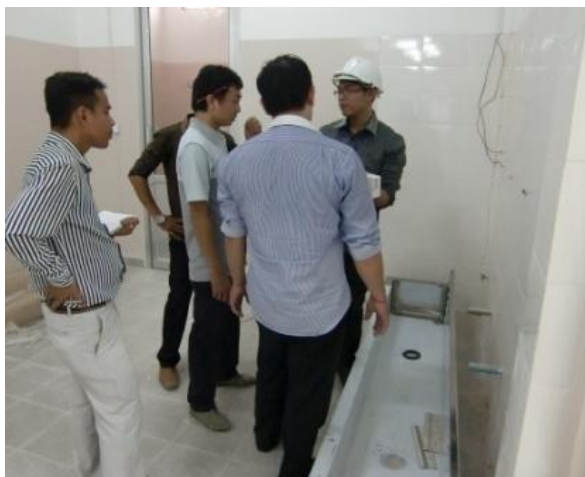
手洗台を設置する様子 (2013年7月)
