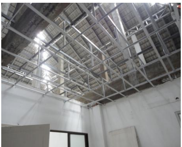
天井張り替えの様子（2013年6月）
