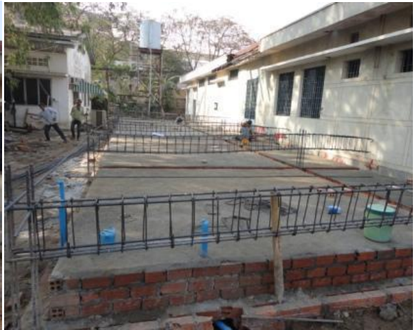
土台の基礎工事の様子（2013年1月）
