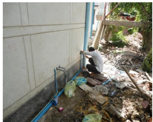
水道管配備の様子（2013年7月）
