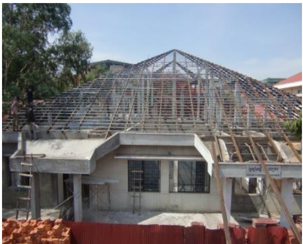
屋根工事の様子（2013年5月）
