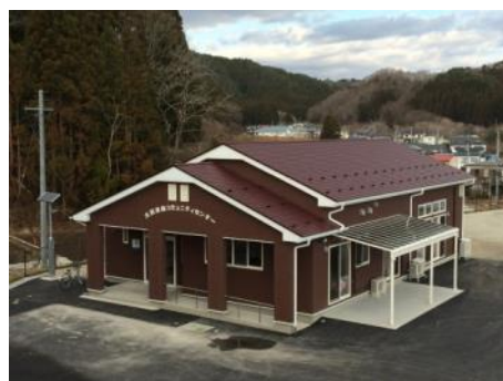
完成した大沢川向コミュニティーセンター
