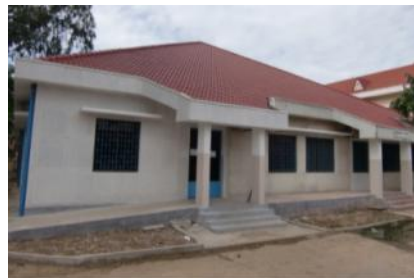
拡張工事が完了した国立小児病院手術棟
