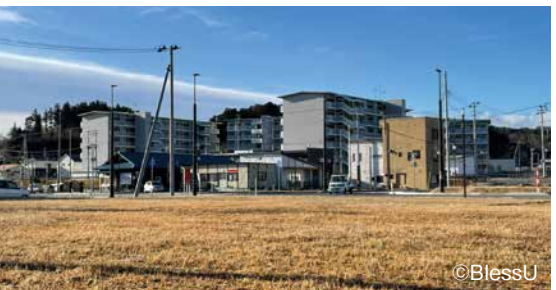
空き地の向こうに見えるのが震災後に建てられた災害公営住宅
