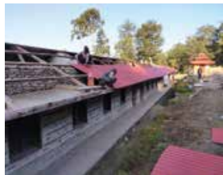
学校の屋根の葺き替えを実施
