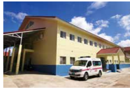
完成したクラチェ州病院の新外科・産科病棟
