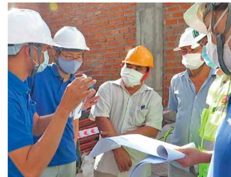
FIDRスタッフと保健局長が工事の進捗をモニタリングしながら質の高い施工を進めています
