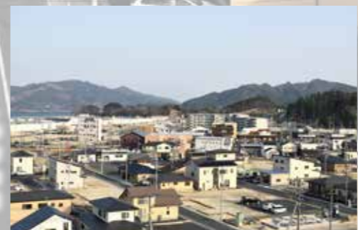
堤防、住宅、商業施設の建設が進む市街地 (2019年4月24日撮影)
