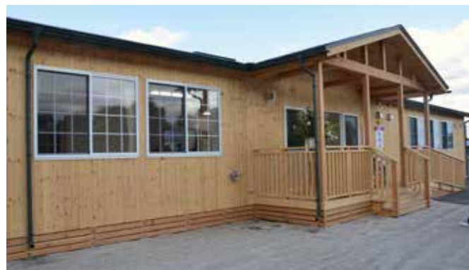
完成した田老保育所仮設園舎（2011年9月）
