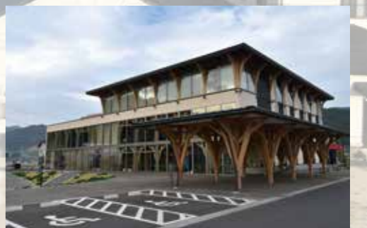
市街地に建てられた交流拠点の大槌町文化交流センター (2019年4月24日撮影)
