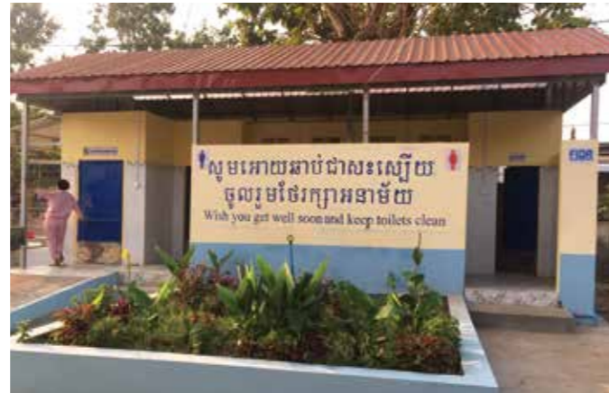
新設したトイレ。男女別に2つの個室とシャワー室を作り、障がい者トイレも併設しました。壁には「どうぞお大事に」のメッセージが描かれています
