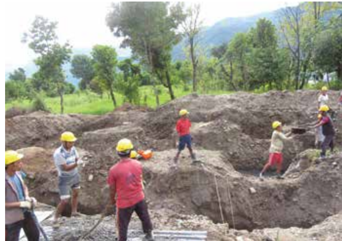
建設が始まったラメチャップ郡のシッダジョティ・ハリミシュラ小中学校（9月）。重機が入ることが難しい山岳地では、作業の多くは人力で進められます
