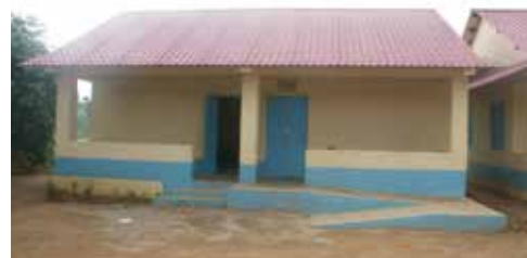
【スンニャカンニャ中学校】将来の地震に耐える鉄筋コンクリート構造の頑丈な校舎
