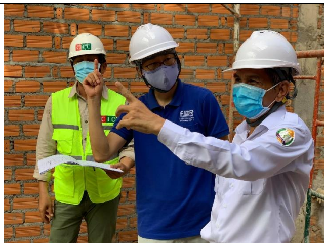
1-3-2 外科棟の移転建設 施工管理委員会 (左から、施工会社、FIDR 佐伯所長、州保健局長)
