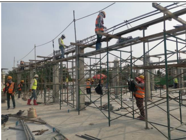
1-3-2 外科棟の移転建設 1階と2階を結ぶ柱建設の様子
